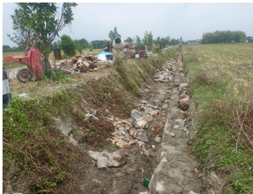
Gambar 1. Kondisi Daerah Irigasi (DI) Desa Putat Lor Sebelum Konstruksi
