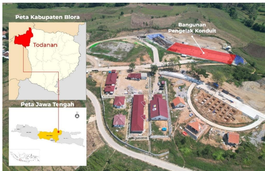
Picture 1. Lokasi Bangunan Pengelak Konduit Bendungan Cabean (Dokumentasi Penulis, 2025)
